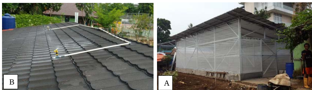
Gambar 1. (A) Bangunan kandang kelinci dengan dinding insect net/screen net dan (B) pemasangan sprinkle penyiraman air di atap
